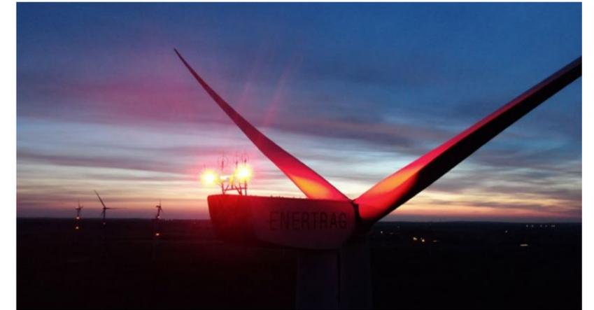
mit bloßem Auge nicht. BNK-Systeme sind bis Ende 2022 für fast alle Bestands-WEA verpflichtend, sonst kann die Marktprämie entfallen. ENERTRAG bietet Betreibern alle Dienstleistungen zur BNK aus einer Hand: ENERTRAG Systemtechnik liefert moderne Befeuerungsanlagen mit zugelassenen Infrarotleuchten und ENERTRAG Service installiert
